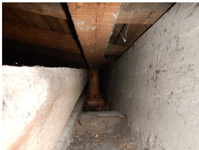
Foto č. 17- NV4 – detail ukončení trámu; Foto č. 18- krov I. (původní část)- celkový pohled;
