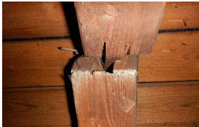
Foto č. 27 - krov I. (původní část)- detail napadení ; Foto č. 28- krov I. (původní část) -zatékání
