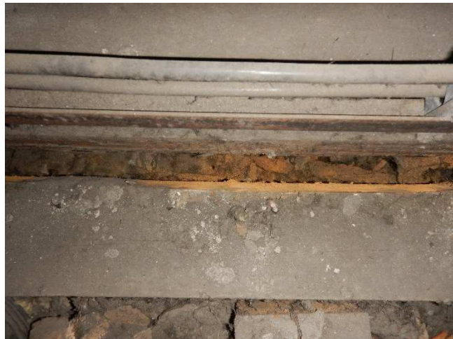
Foto č. 23; 24- krov I. (původní část)- nefunkční spoj ve vrcholu krokví;
