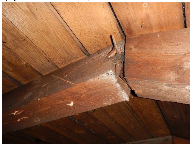
Foto č. 25; 26- krov I. (původní část)- detail nefunkční spoj krokví a pásku
