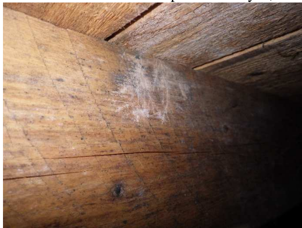
Foto č. 44-49 krov II. (přístavba)- prvky napadené dřevokaznou houbou- prorůstání hyfu;
