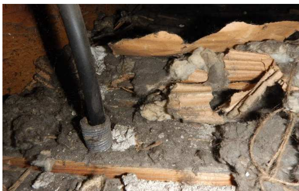
Foto č. 7 – NV2 – izolační skladba zateplení;
