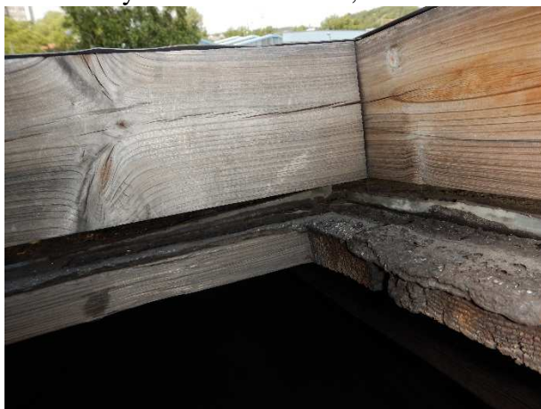
Foto č. 29; 30- krov I.(původní část)- detail řešení skladby střešní konstrukce;
