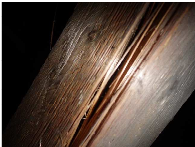
Foto č. 39 -43- krov II.(přístavba)- 9 A- lokalita havarijního stavu- rozpad, výskyt plodnic, zatékání;
