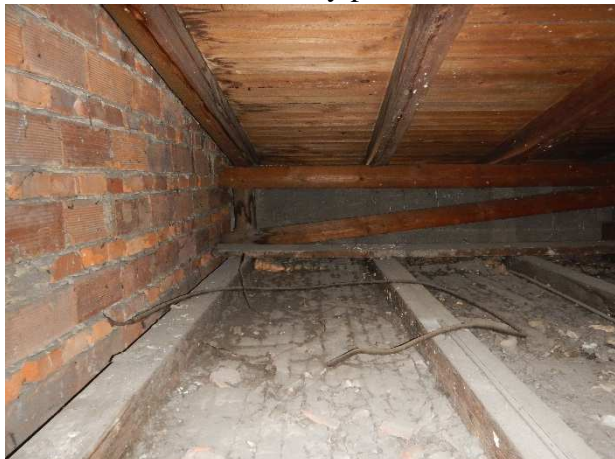
Foto č. 3 - NV1-mezera mezi trámem a stěnou; Foto č. 4 - NV2 celkový pohled;
