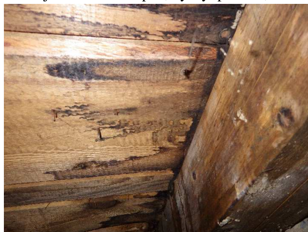
Foto č. 39 -43- krov II.(přístavba)- 9 A- lokalita havarijního stavu- rozpad, výskyt plodnic, zatékání;
