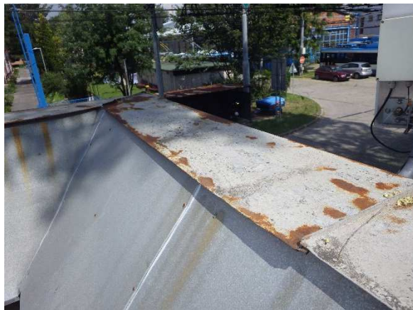
Foto č. 62; 63 - střecha- zanesení plochy biotickými činiteli a náletovou zelení;
