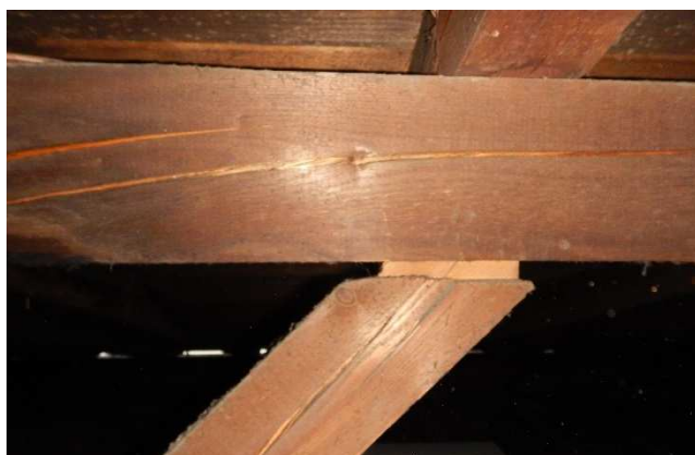
Foto č. 27 - krov I. (původní část)- detail napadení ; Foto č. 28- krov I. (původní část) -zatékání
