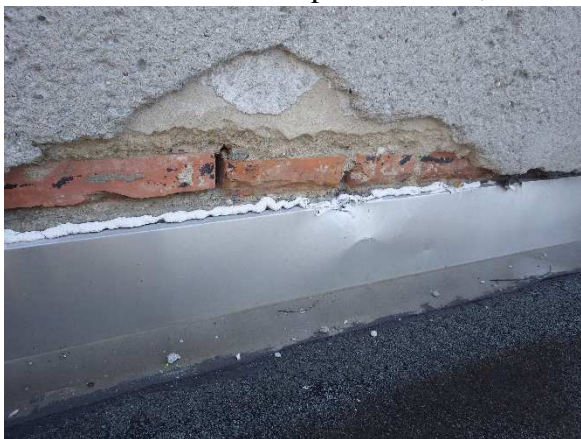
Foto č. 66; 67 střecha- oplechování a návaznost na obvodovou stěnu- pohled/detail;
