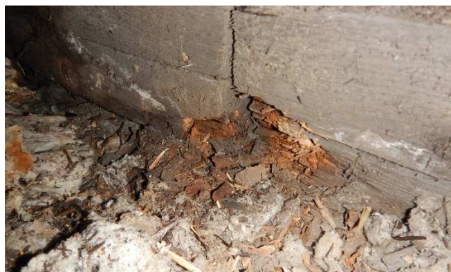
Foto č. 27 - krov I. (původní část)- detail napadení ; Foto č. 28- krov I. (původní část) -zatékání
