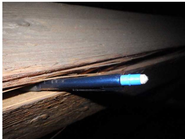
Foto č. 39 -43- krov II.(přístavba)- 9 A- lokalita havarijního stavu- rozpad, výskyt plodnic, zatékání;
