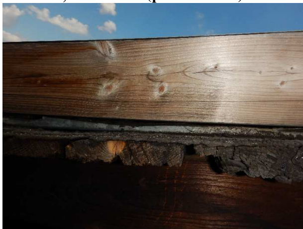
Foto č. 31; 32- dilatace mezi objekty- lokalita zatékání;
