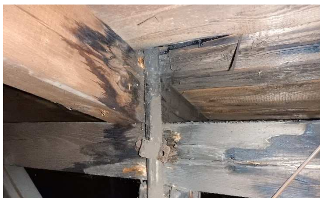
Foto č. 27 - krov I. (původní část)- detail napadení ; Foto č. 28- krov I. (původní část) -zatékání
