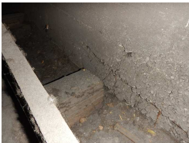
Foto č. 6 – NV2 - mezera mezi trámem a stěnou;
