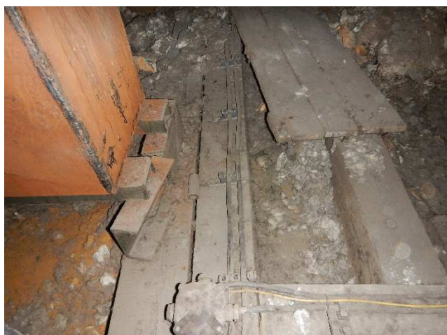
Foto č. 14- NV3– mezera mezi trámem a stěnou;
