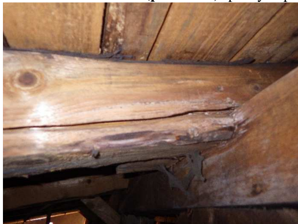
Foto č. 44-49 krov II. (přístavba)- prvky napadené dřevokaznou houbou- prorůstání hyfu;
