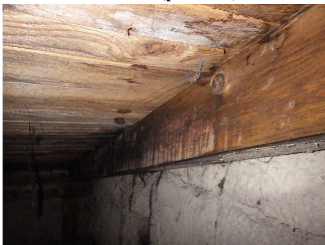
Foto č. 39 -43- krov II.(přístavba)- 9 A- lokalita havarijního stavu- rozpad, výskyt plodnic, zatékání;
