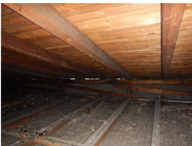
Foto č. 6 – NV2 - mezera mezi trámem a stěnou;
