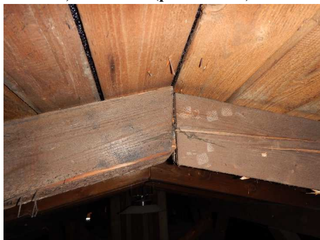
Foto č. 25; 26- krov I. (původní část)- detail nefunkční spoj krokví a pásku
